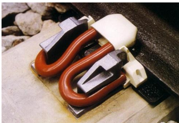
Рисунок 1.25 – Рельсовое крепление Пандрол-350
