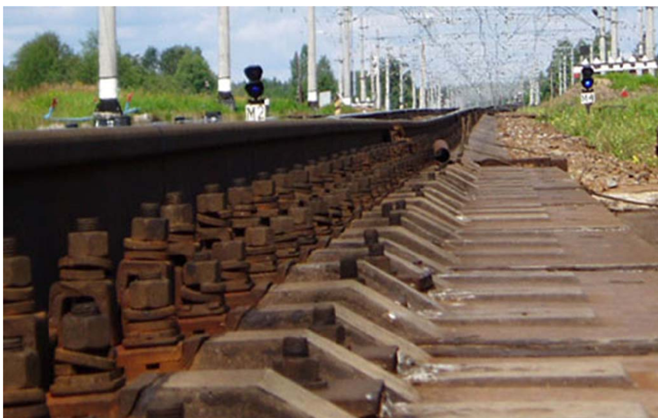
Рисунок 1.1 – Общий вид пути с предмостовой ямой
