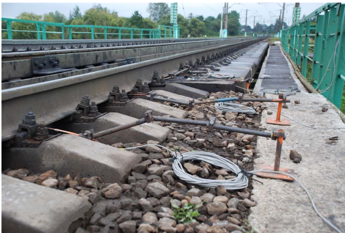
Рисунок 2.9 – Общий вид экспериментального участка в зоне сопряжения земляного полотна и ИССО
