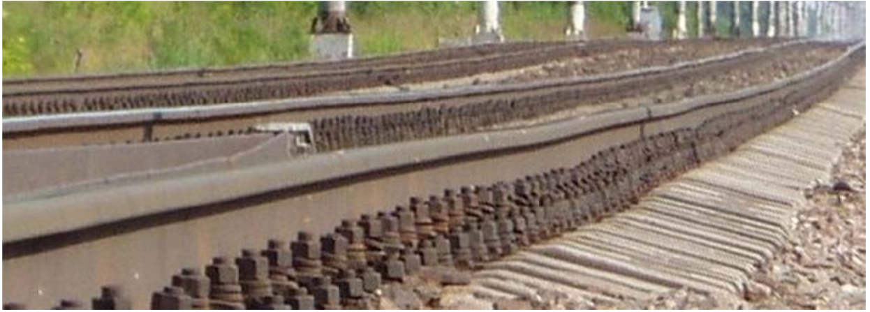
Рисунок 3.10 – Фото неровностей на подходе к мосту через реку Осеченку на Октябрьской железной дороге
