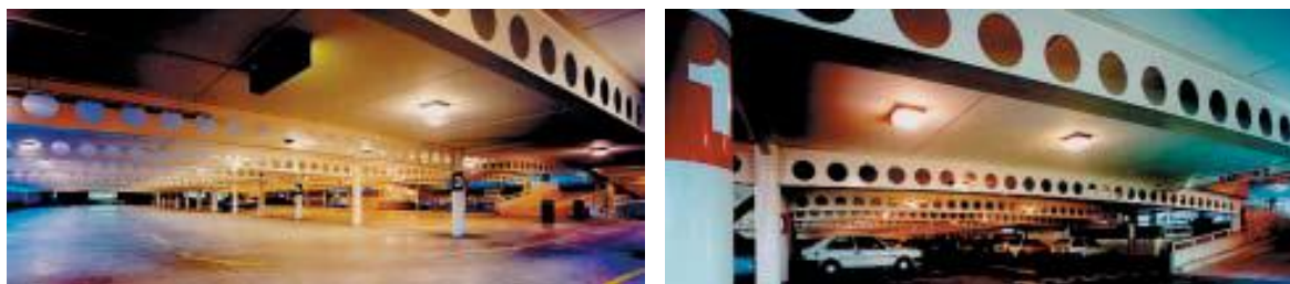
Рисунок 1.3 – Пример использования балок с перфорированной стенкой в парковке торгового центра в Ньюри (Великобритания)
