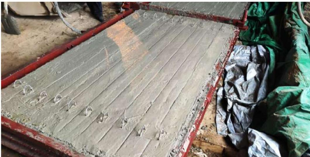
Рисунок Д.6 – Поверхность уложенной бетонной смеси после сглаживания
