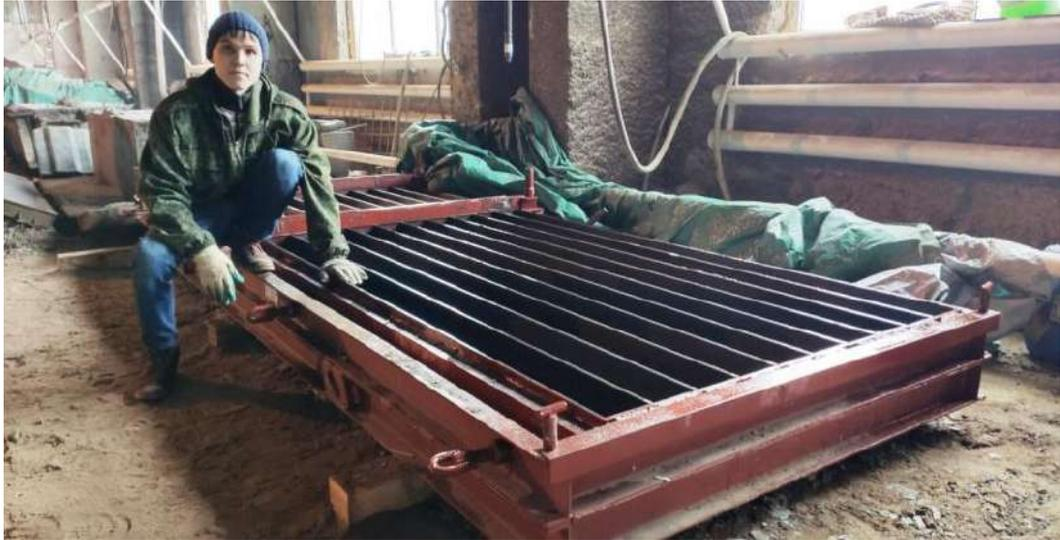
Рисунок Д.4 – Подготовка опалубки
