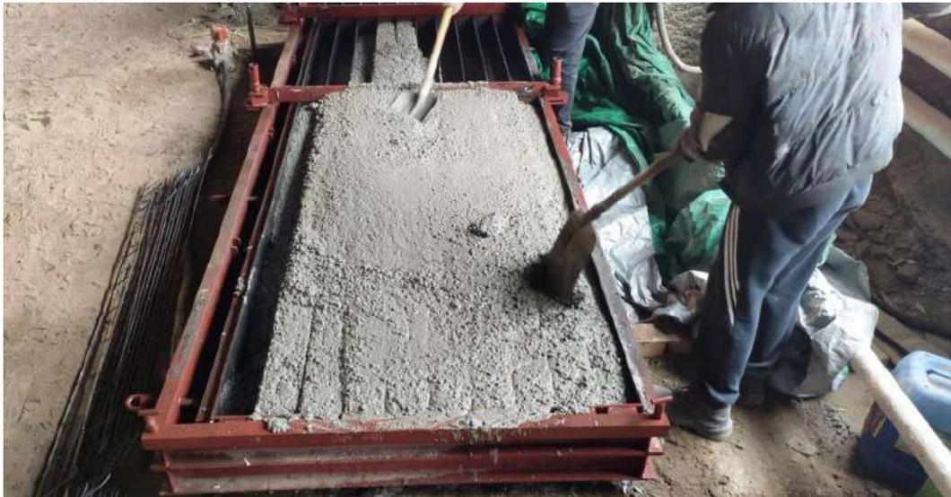
Рисунок Д.5 – Укладка готовой бетонной смеси в формы
