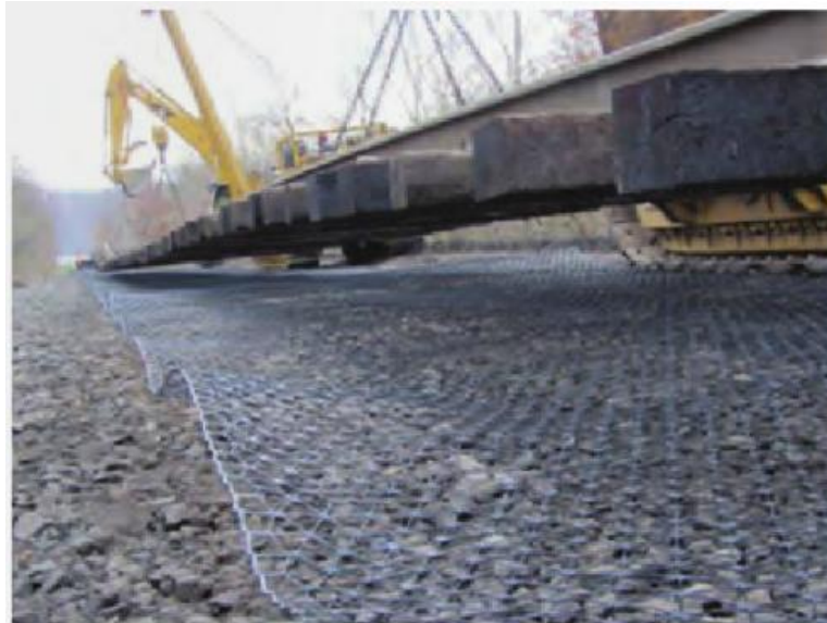
Рисунок 1.5 – Установка георешетки на основную площадку (подбалласт)
