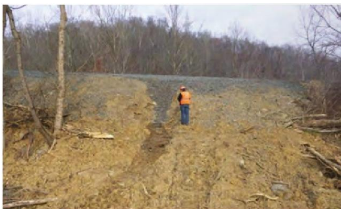
Рисунок 1.7 – Дренаж балласта продолжает функционировать спустя месяц после установки
