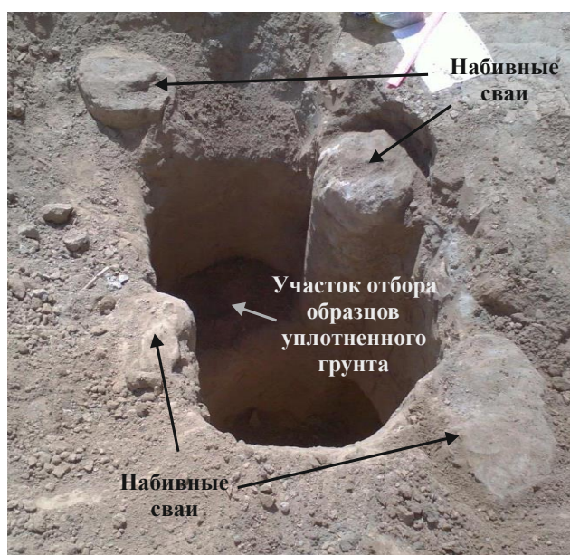
Рисунок 7 – Шурф, вскрытый около набивных свай
