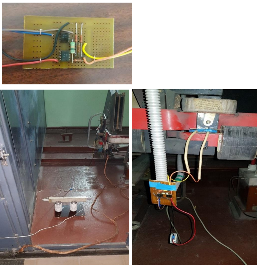
Рисунок 14 – Схема блокировки с РДШ(М) на ПЛТС
