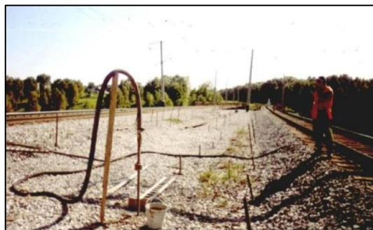
Рисунок 27 – Усиление насыпи на 15-м км перегона Дедюево – Буреничево: а – общий вид насыпи; б – инъектирование раствора
