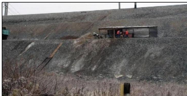
Рисунок 27 – Усиление насыпи на 15-м км перегона Дедюево – Буреничево: а – общий вид насыпи; б – инъектирование раствора
