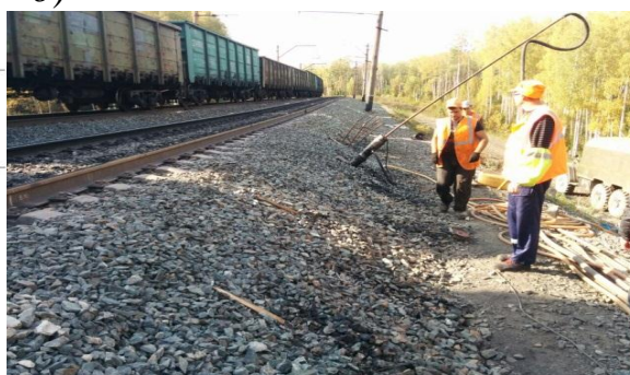
Рисунок 28 – Усиление насыпи на 146-м км линии Голуха – Тягун: а – конструктивная схема армирования; б – процесс инъецирования
