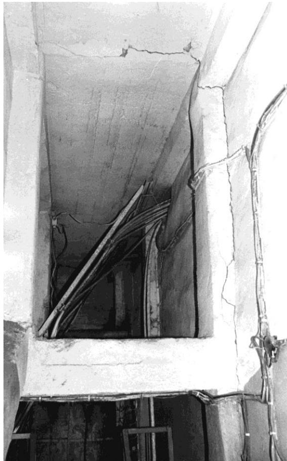
Рисунок 2.14 – Трещина по монолитному перекрытию и в зоне примыкания колонны к стене. Станция «Черная речка»
