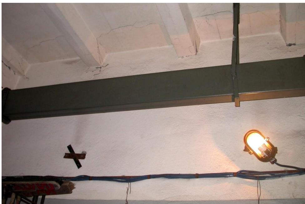
Рисунок 2.33 – Станция «Ладожская». Трещины в приопорных зонах плит перекрытия 2-го этажа
