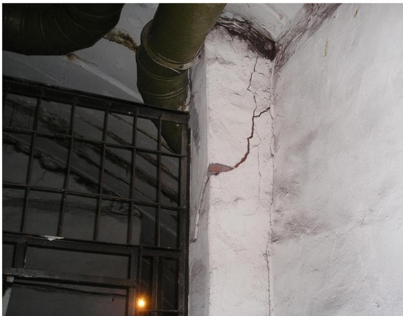
Рисунок 2.44 – Станция «Удельная». Трещины раздавливания в колонне наружного ряда
