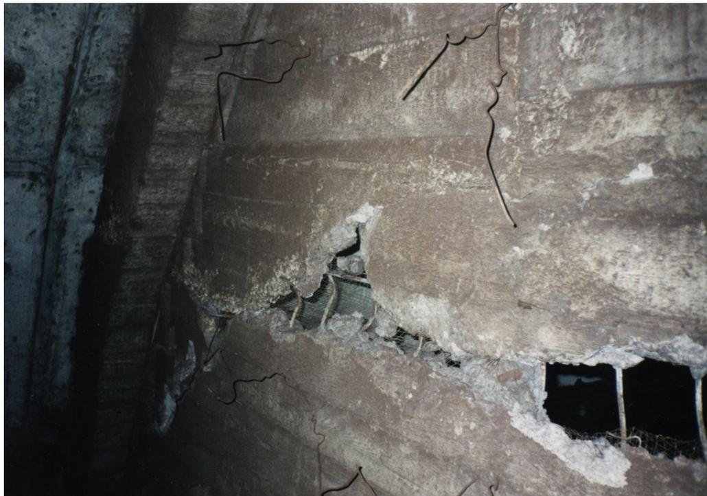
Рисунок 2.18 – Разрушение лобовой железобетонной мембраны. Вид со стороны тоннеля
