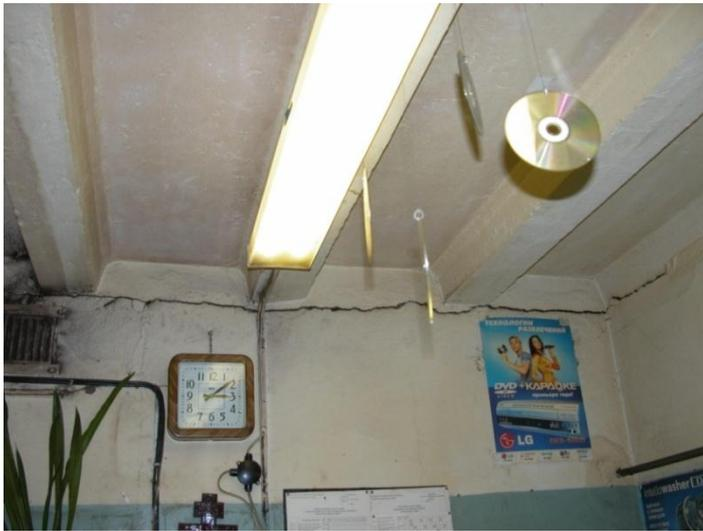
Рисунок 2.26 – Станция «Лиговский проспект». Нарушение стыков опирания плит покрытия платформы на продольные стены
