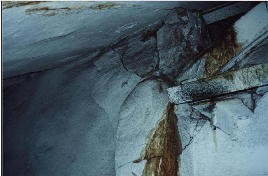
Рисунок 2.35 – Станция «Пионерская». Повреждения перегородки и зонта на втором этаже СТП
