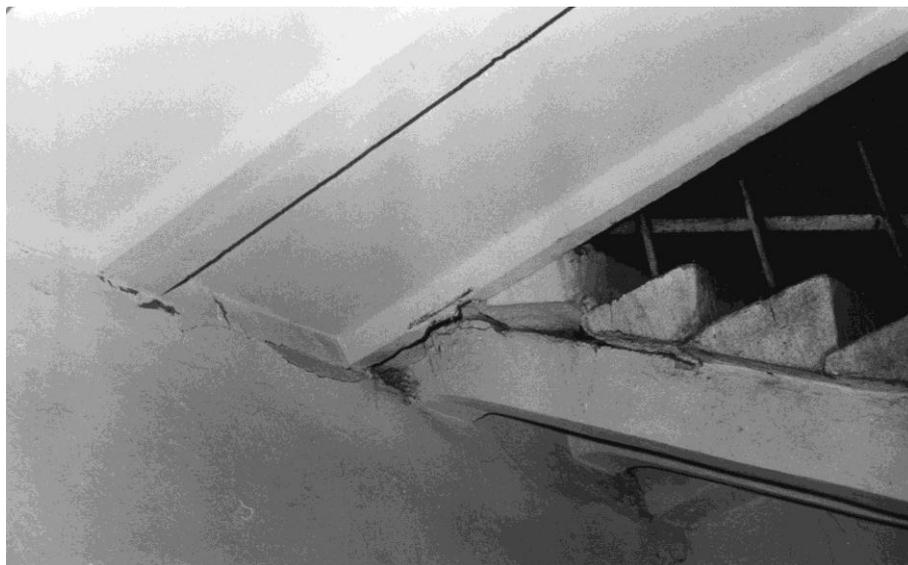
Рисунок 2.5– Смятие стены мастерской перекрытием второго этажа и повреждение лестничного марша
