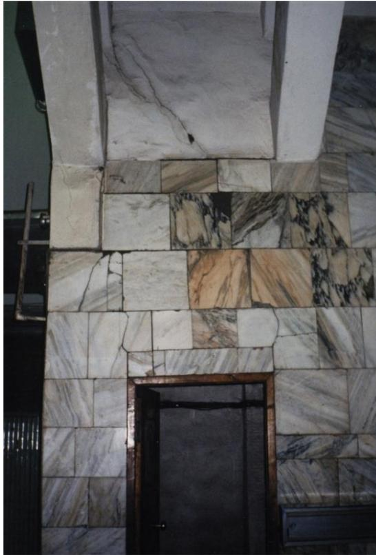
Рисунок 2.19 – Деформации дверного проема и участка стены пешеходного перехода к эскалаторам
