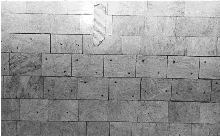
Рисунок 2.3 – Закрепление бунящих участков специальными анкерами
