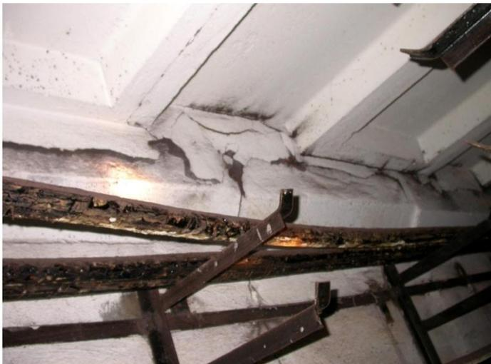
Рисунок 2.27 – Станция «Ладожская». Трещины и деформации ребер плит в зоне опирания на стены кабельного коллектора
