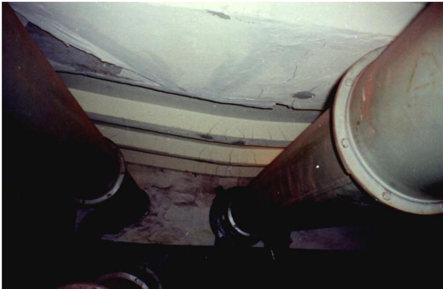
Рисунок 2.31 – Станция “Пионерская». Вентиляторная. Сверхнормативный прогиб и трещины в ребрах сборных плит вентиляторной
