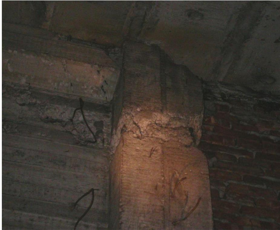
Рисунок 2.45 – Станция «Обухово». Раздавливание колонны между верхним и обратным сводом. Трещины в стыке с горизонтальной обвязочной балкой
