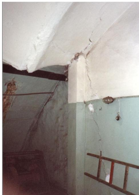
Рисунок 2.40 – Станция «Пионерская». Раз-давливание зонта колонной каркаса
