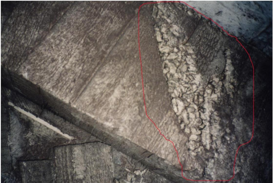
Рисунок 2.21– Участок непровибрированного бетона монолитной арки
