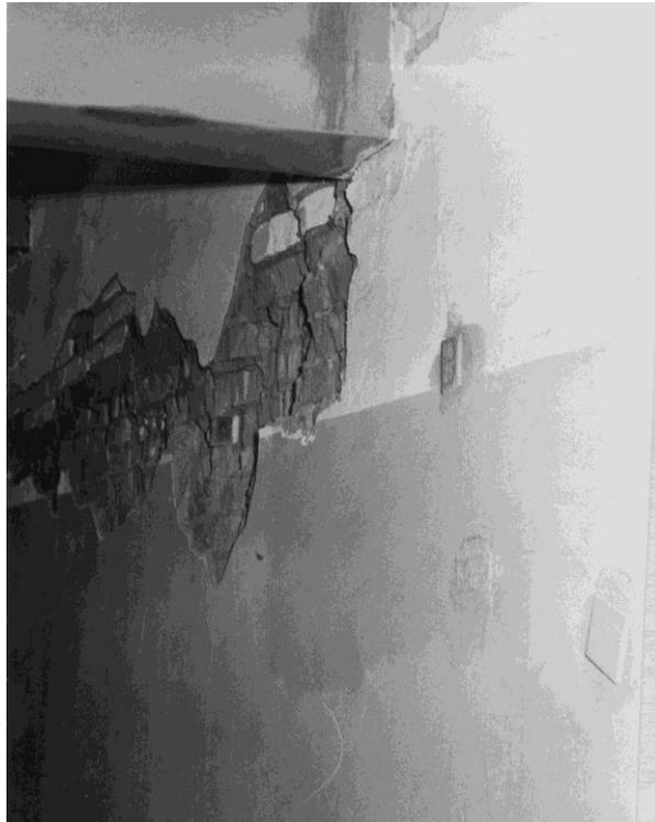
Рисунок 2.4 – Вывал в кирпичной стене. Коридор блока служебных помещений (БСП)
