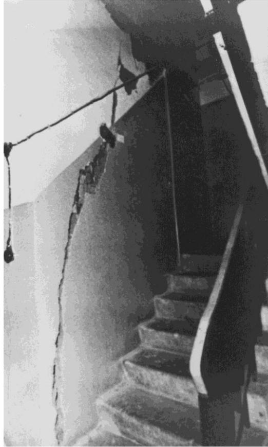
Рисунок 2.9 – Трещина по стене и вывал на ст. «Черная речка» СТП-29
