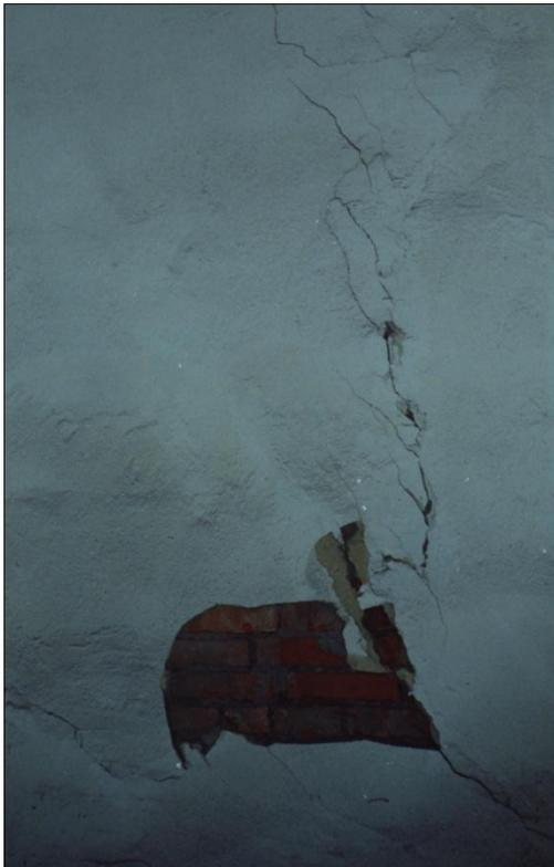
Рисунок 2.36 – Станция «Удельная». Повреждения путевой стены. Вид из аккумуляторной СТП
