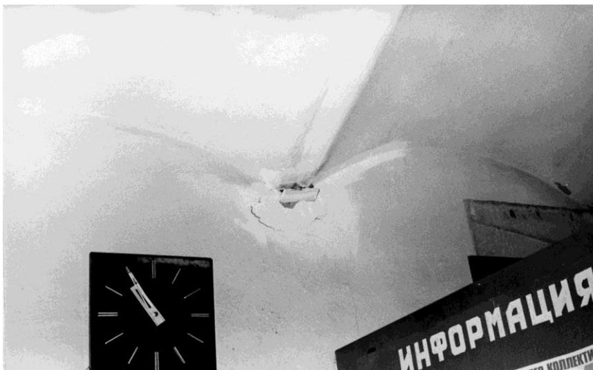
Рисунок 2.6 – Продавливание зонта кламмером в СТП
