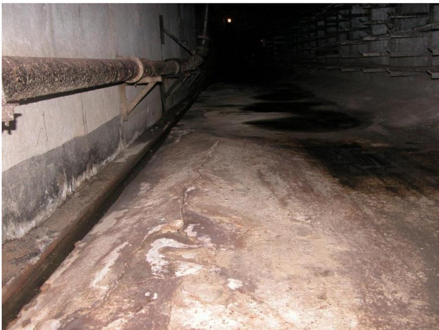
Рисунок 2.29 – Станция «Новочеркасская». Деформации (выпучивание) пола вдоль продольной стены кабельного коллектора
