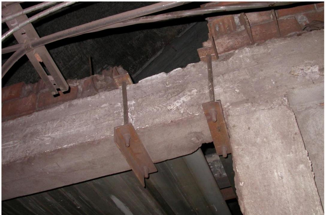
Рисунок 2.46 – Станция «Пионерская». Конструкция усиления стыка надпутевой балки, с вертикальной стойкой каркаса СТП
