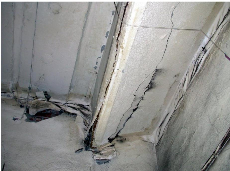
Рисунок 2.32 – Станция «Озерки». Повреждение зонта и выдавливание демпфирующего слоя в помещении мастерской
