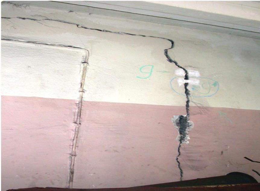
Рисунок 2.28 – Станция «Ладожская». Трещина в поперечной стене между служебными помещениями
