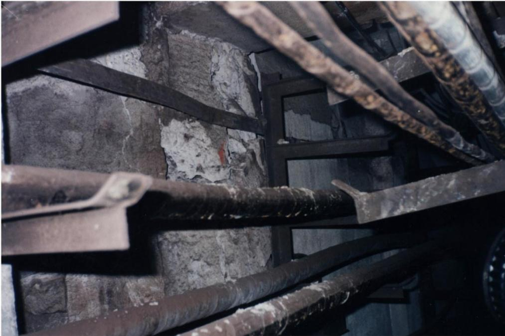
Рисунок 2.22 – Разрушение участка опорной стойки в уровне подплатформенных коллекторов
