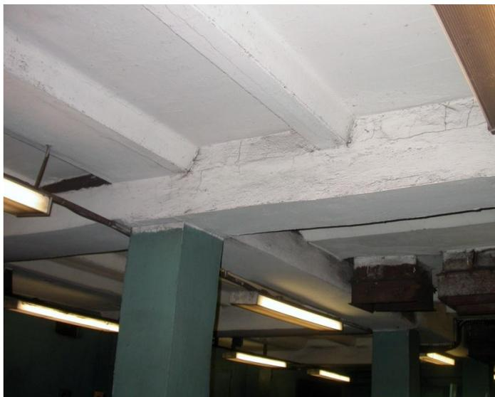
Рисунок 2.41– Станция «Садовая». Сеть трещин в зоне опирания плит перекрытия
