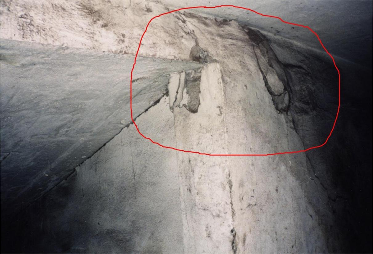
Рисунок 2.23 – Следы поднятия обратного свода на внутренних конструкциях зоны торцевой стены
