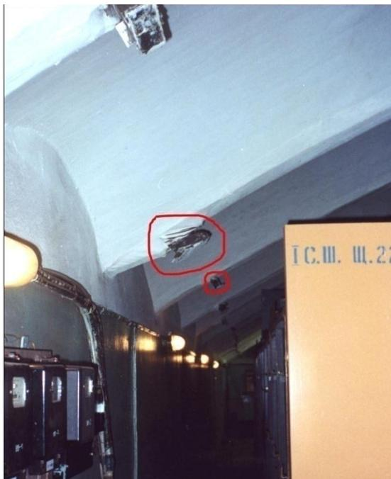
Рисунок 2.39 – Станция «Проспект Большеви-ков». Отрыв зонтов от кламмеров
