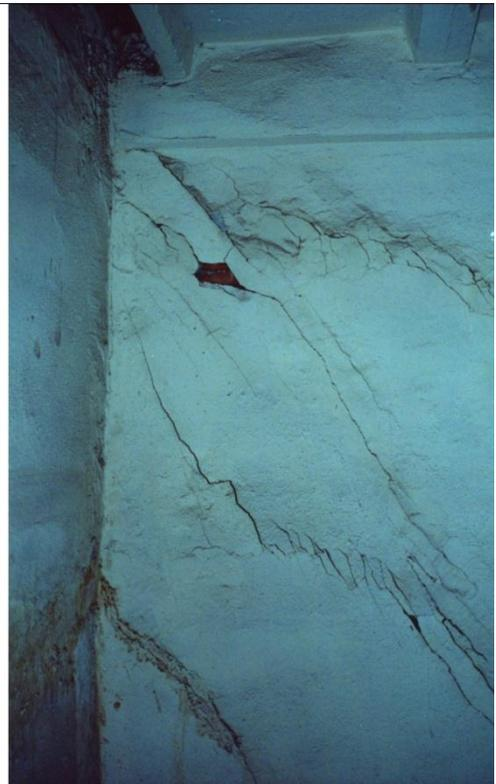
Рисунок 2.37– Подвал СТП. Сеть наклонных трещин в поперечной перегородке
