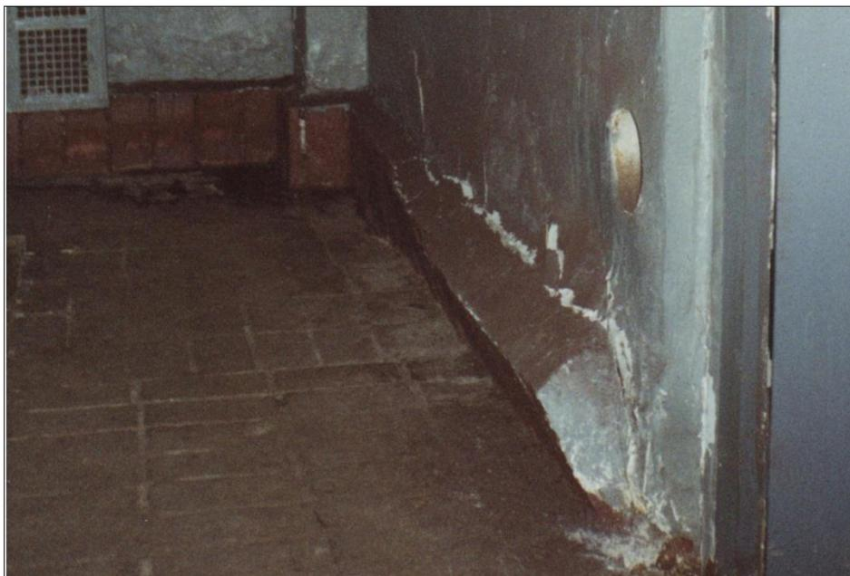
Рисунок 2.38 – Станция «Новочеркасская». Продольная перегородка первого этажа. Горизонтальная трещина с выдавливанием кладки
