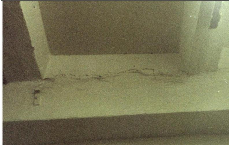
Рисунок 2.42– Станция «Проспект Большевиков». Горизонтальные трещины в местах прилегания сборных плит к балкам перекрытия
