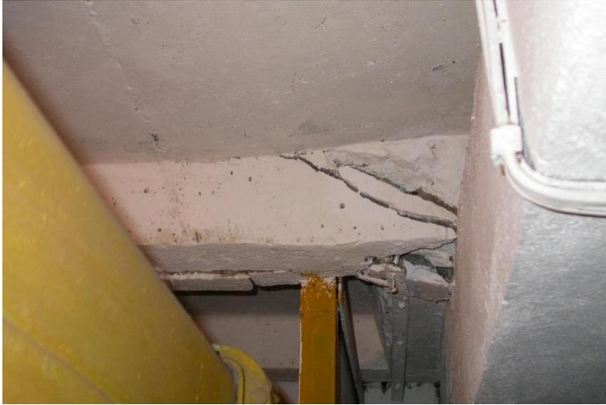
Рисунок 2.30 – Станция “Удельная». Санузел ГО. Разрушение продольного ребра сборной плиты перекрытия по наклонным трещинам с одновременным отрывом поперечного ребра от полки
