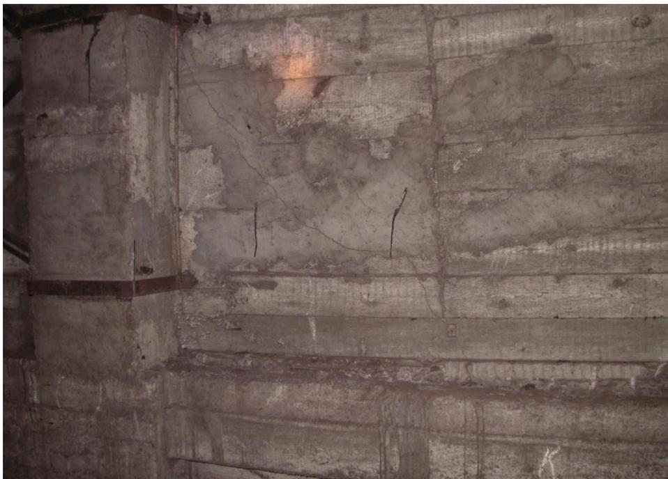
Рисунок 2.43 – Станция «Лиговский проспект». Трещины в колонне наружного ряда, обвязочной балке и путевой стене
