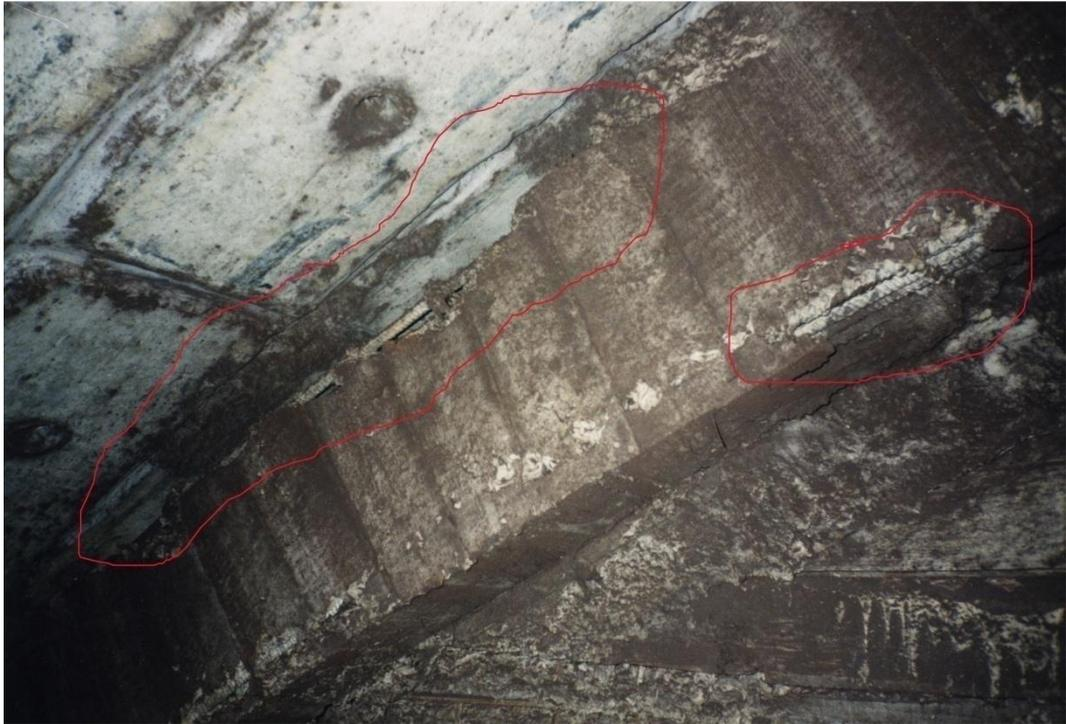
Рисунок 2.20 – Обнажения рабочей арматуры монолитной арки
