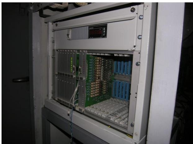
*а – электрический шкаф МСУЭ с одним полукомплектом модулей и кабелем для перепрограммирования (ДЦВ Красноярской ж.д.)*
