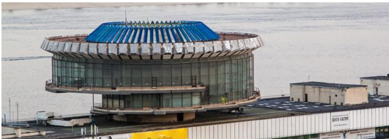
Рис.1.9 Волгоград, здание речного порта, фрагмент
