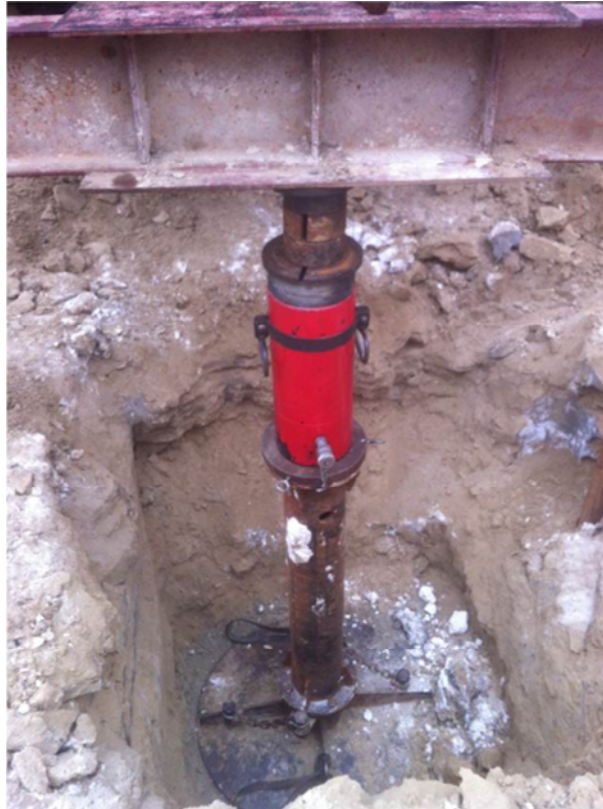
Рисунок 2.9 – Технологические операции проведения штамповых испытаний в шурфах (глубиной до 1,5 м):
