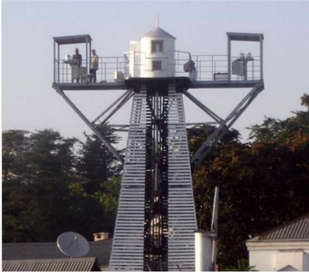
Рисунок А.7 – Вышка лазерного створного маяка «Анемон» [116]
