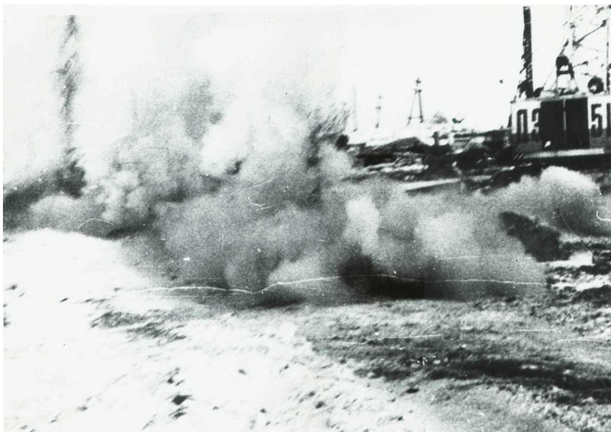
Рис. 1.11. Взрыв зарядов на подготовленном участке уплотнения основания
