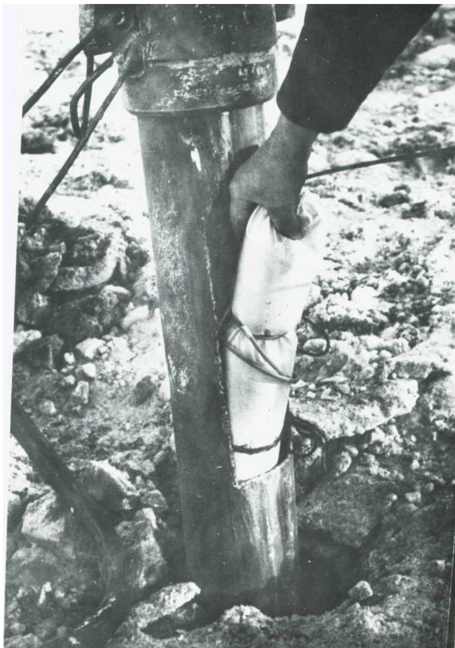
Рис. 1.10. Опускание зарядов взрывчатого вещества внутри погруженной обсадной трубы
