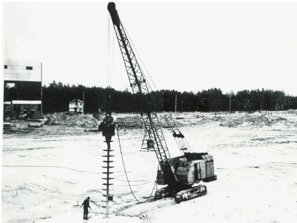
Рис. 1.15. Общий вид виброустановки конструкции ВНИИГС при уплотнении основания
