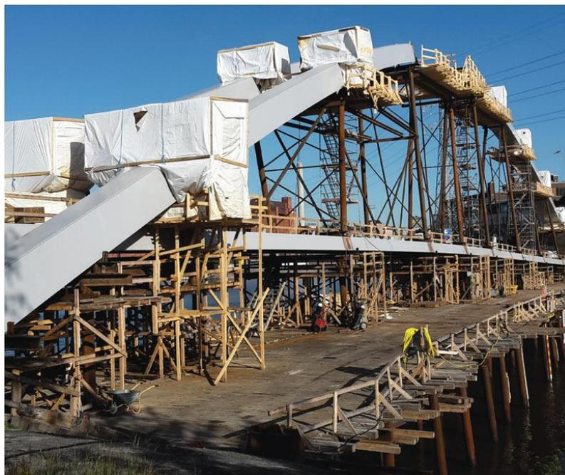
Рисунок 15 – Монтаж металлоконструкций моста
