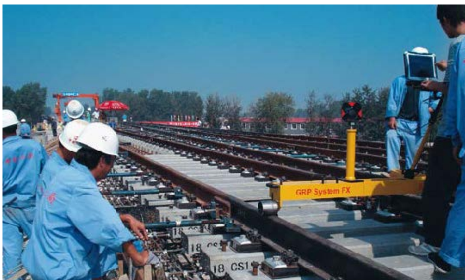
Рисунок 16 – Применение Amberg Slab Track при укладке пути
