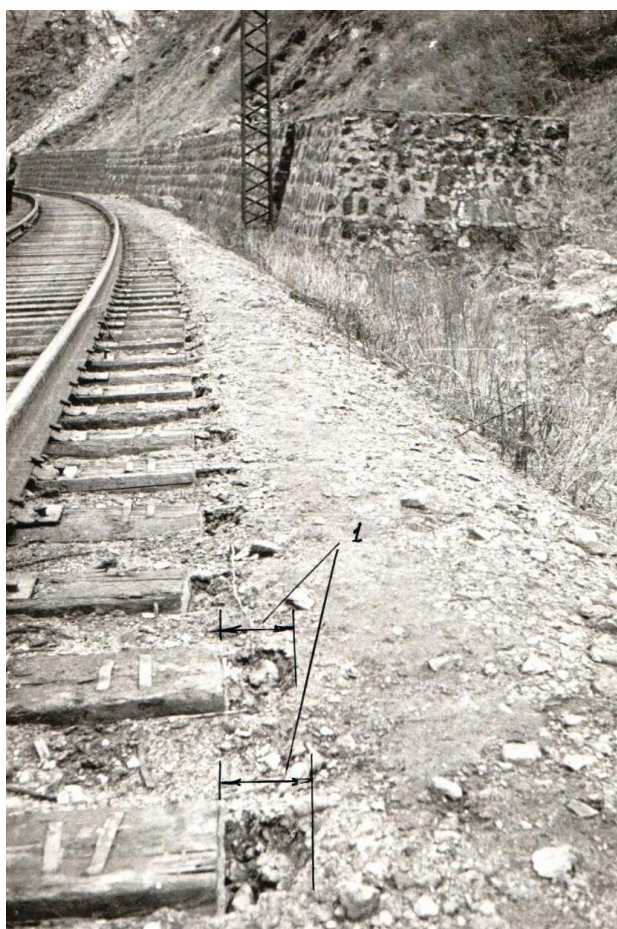
Рисунок 2.2 – Смещение рельсошпальной решётки (1) в сторону откоса полунасыпи
