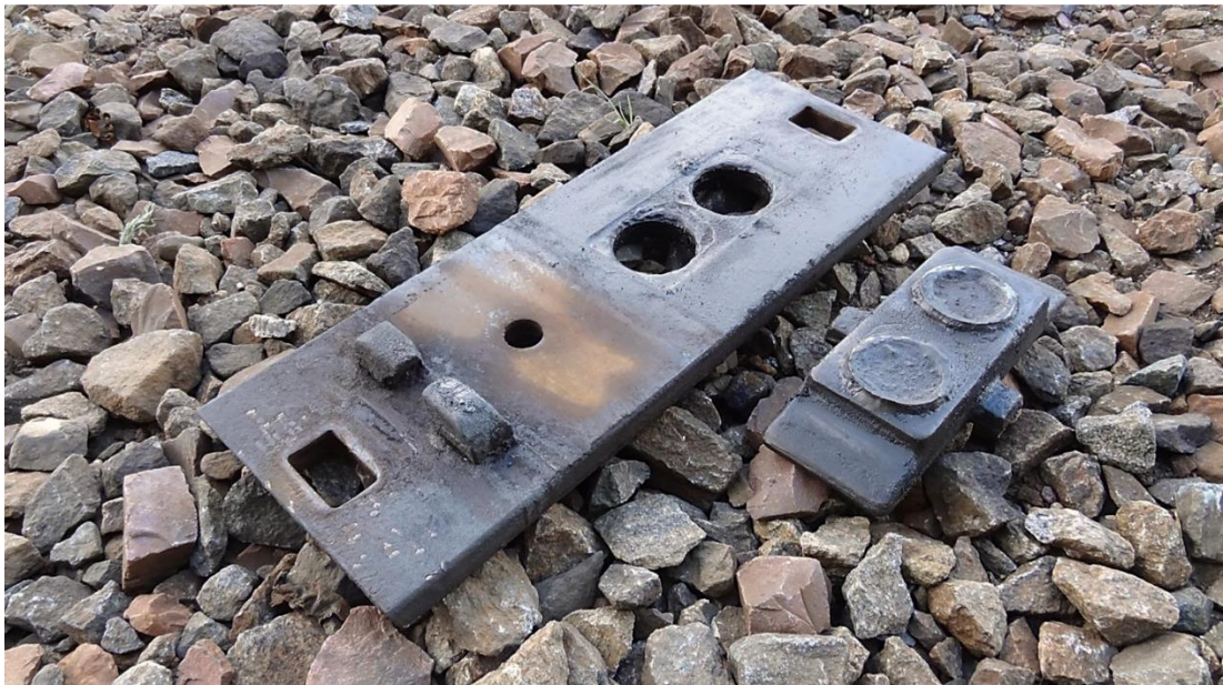
Рисунок 2.5 - Новый вид дефекта подкладки с приварной подушкой
