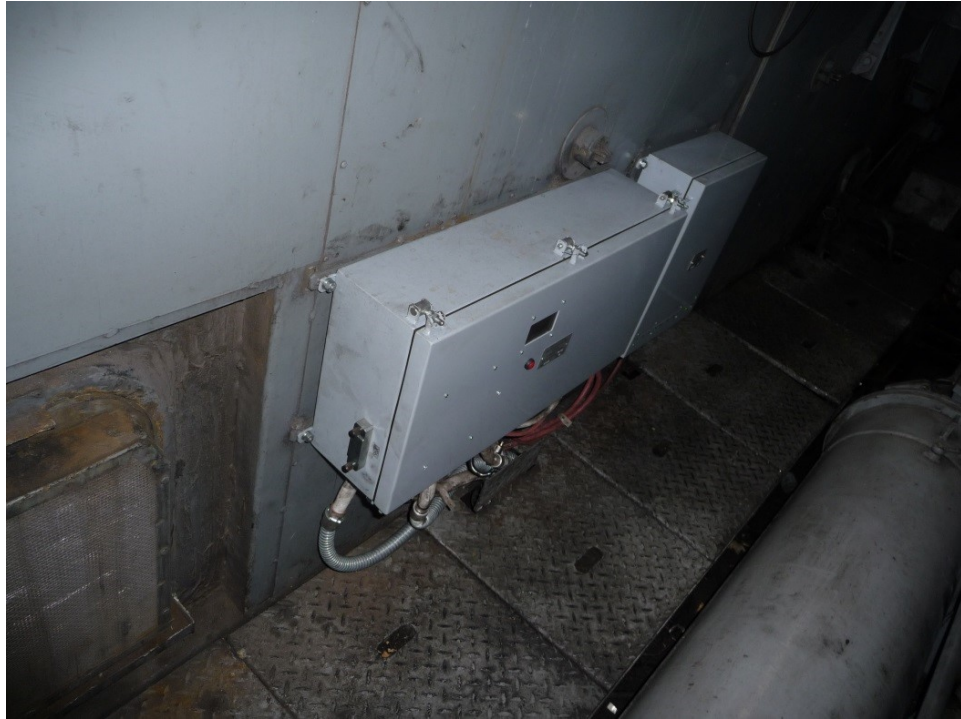
Рисунок 19 - Блоки управления и питания системы ЭСУТПН
