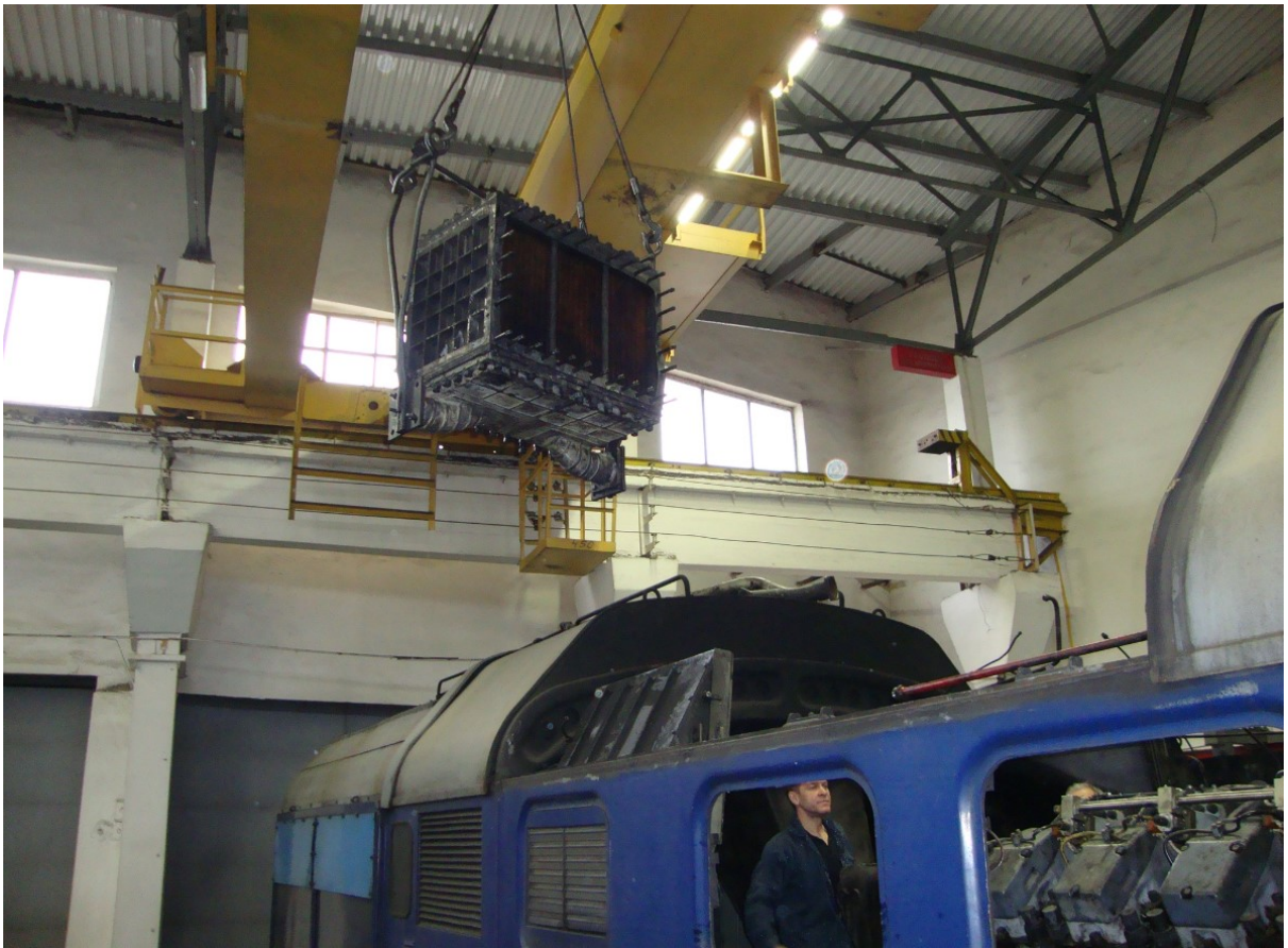
Рисунок ДЗ - Установка охладителя наддувочного воздуха после промывки
