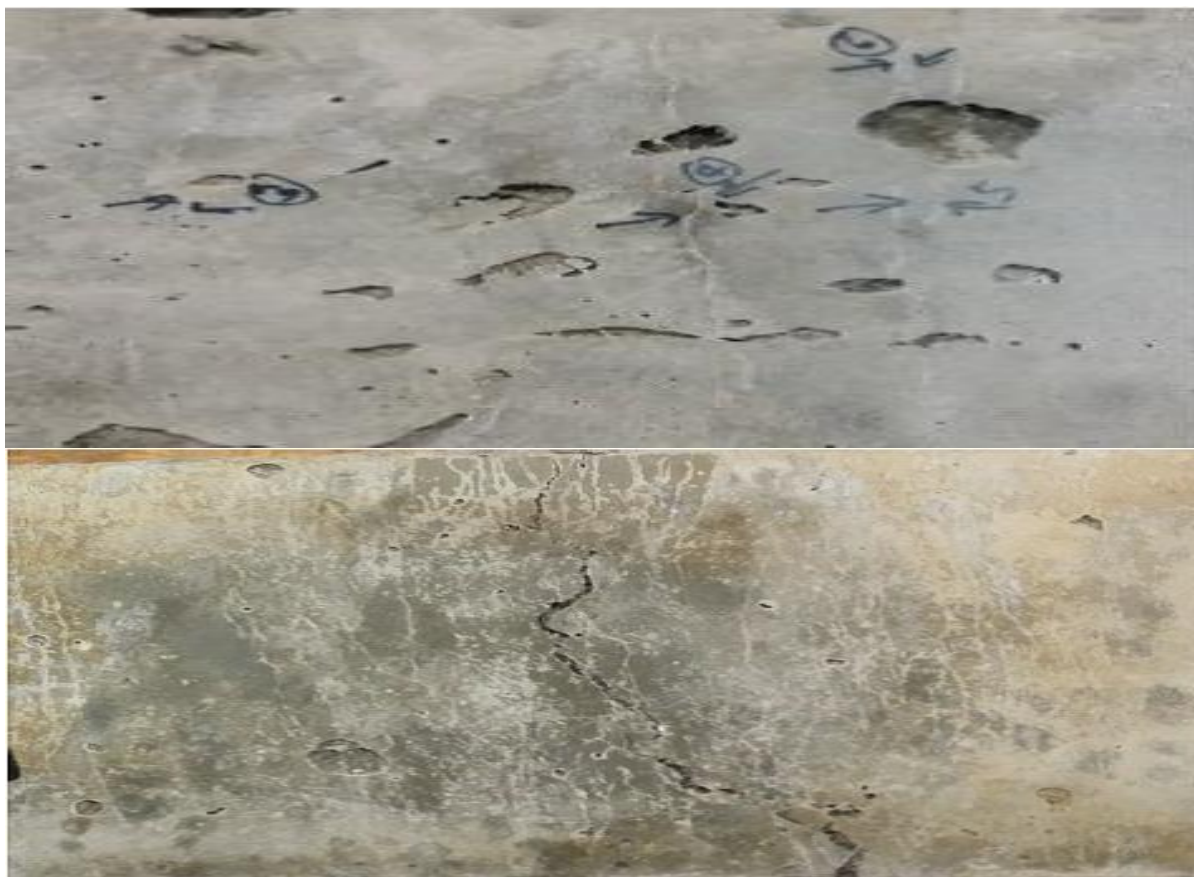
Рисунок 4.57 – Залеченные трещины в образцах из ЕСС с иммобилизованными в цеолите бактериями S. pasteurii (вверху); все микротрещины оказались заполненными белым осадком (внизу)
