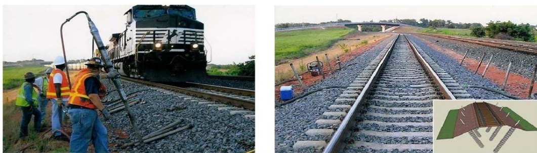
Рисунок 1.7 – Инъектирование твердеющих растворов при усилении земляного полотна железных дорог (США)
