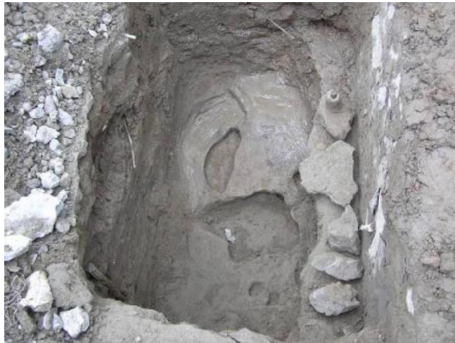
Рисунок 5.32 – Контрольный шурф на контакте с конструкциями трубы
