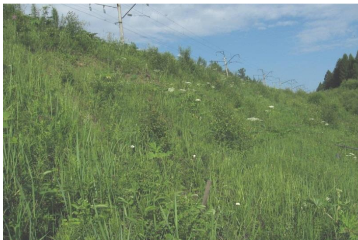
Рисунок 5.33 – Эксплуатируемая высокая насыпь (961-й км, ПК 5, Абакумовская дистанция пути, Красноярская железная дорога)
