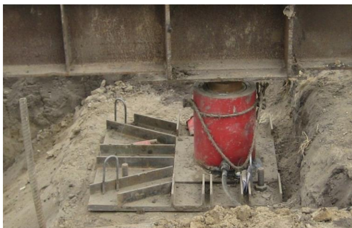
Рисунок 3.9 – Фото штампа, смонтированного на натурной модели насыпи
