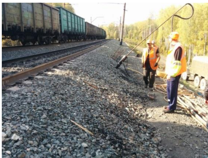
Рисунок 5.40 – Нагнетание твердеющего раствора через инъектор, подключенный к растворной линии
