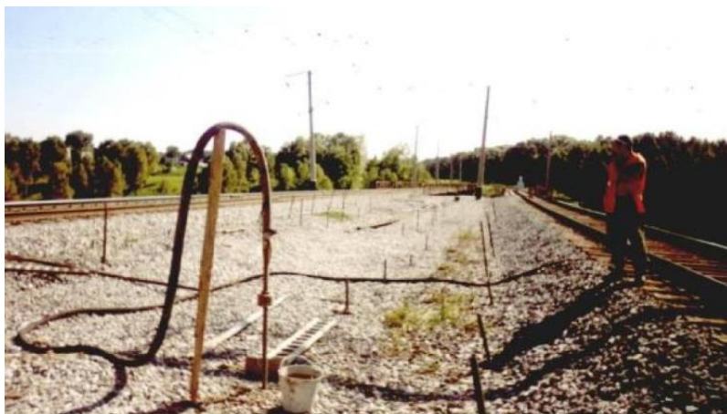
Рисунок 5.28 – Общий вид участка производства работ
