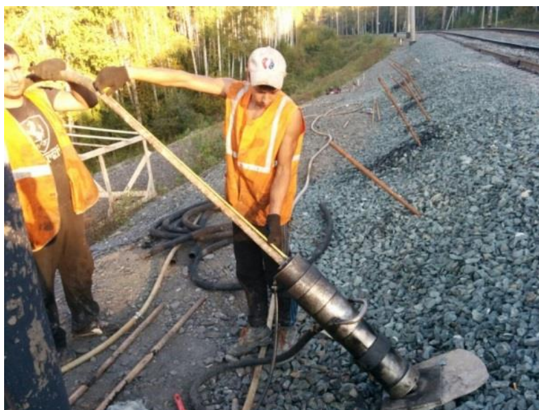
Для реализации проекта усиления использованы инжекторы с теряемыми наконечниками. Погружение инжекторов выполнялось с использованием кольцевых пневмоударных механизмов (рисунок 5.38)
