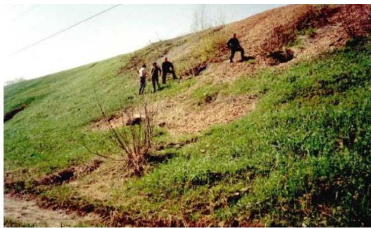
Рисунок 5.30 – Эксплуатируемая высокая насыпь (водопропускная труба, 88-й км линии Алтайская – Бийск, Западно-Сибирская железная дорога)
