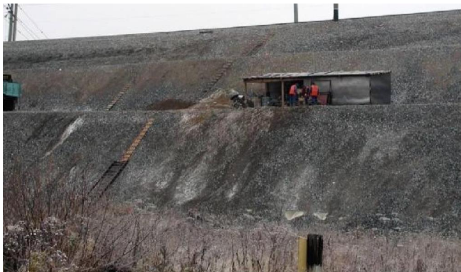
Рисунок 5.24 – Эксплуатируемая высокая насыпь (15-й км, перегон Дедюево – Буреничево, Западно-Сибирская железная дорога)
