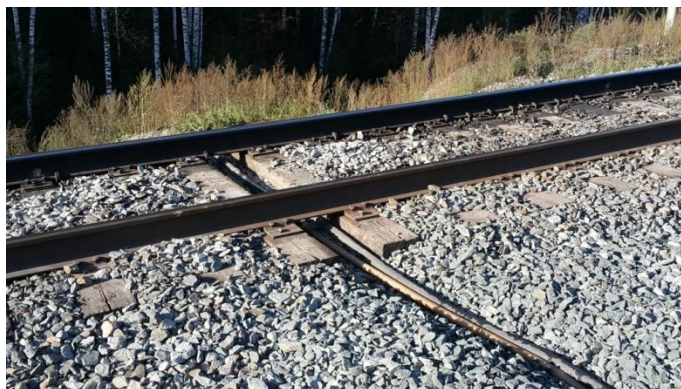
Рисунок 5.41 – Прокладка растворной линии в предварительно подготовленном шпальном ящике
