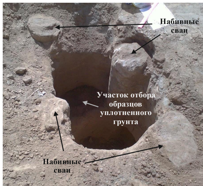
Рисунок 3.22 – Шурф, вскрытый около набивных свай
