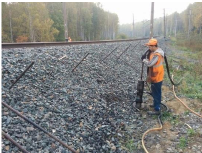
Рисунок 5.39 – Подъем инъектора с использованием режима реверсивного движения пневмоударного механизма
