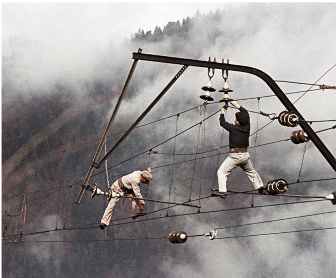
Рисунок 61. Выполнение работ по монтажу проводов ИВП
