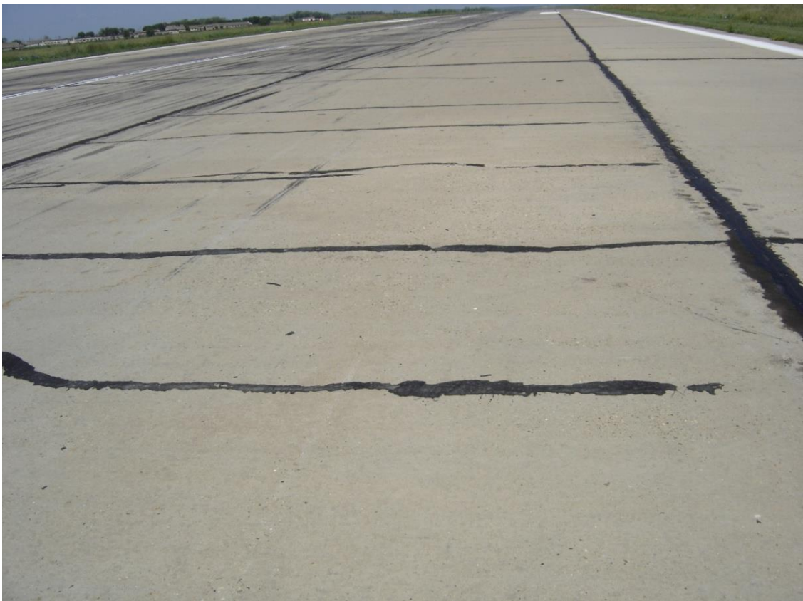
Рисунок 1.2 – Армобетонное покрытие аэродрома Анапа (Витязево)
